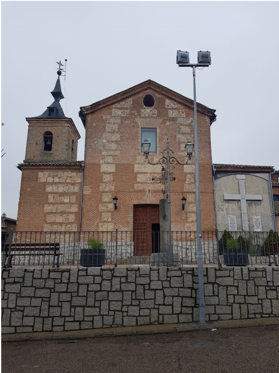
Vista de la fachada principal de la “Iglesia del Triunfo de la Santa Cruz”
