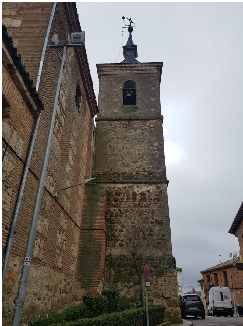
Detalle de la Torre de la Iglesia
